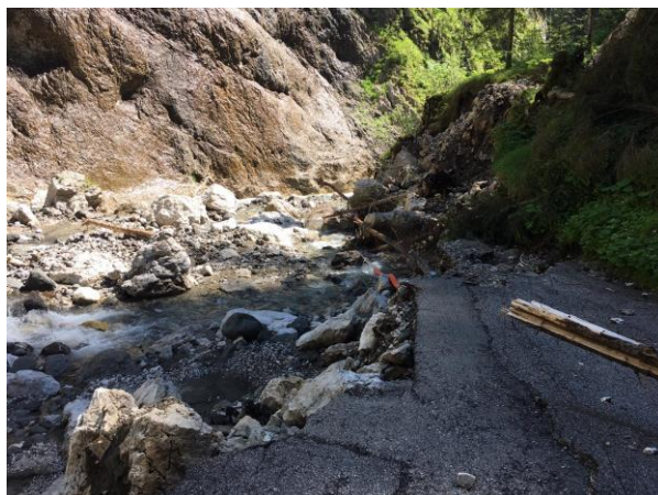
8 – Erosione stradale e materiale in alveo del t. Pettorina
