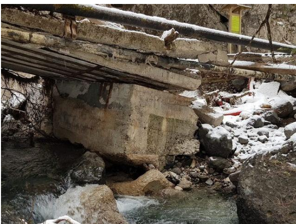
4 – Ponte distrutto sul t. Pettorina
