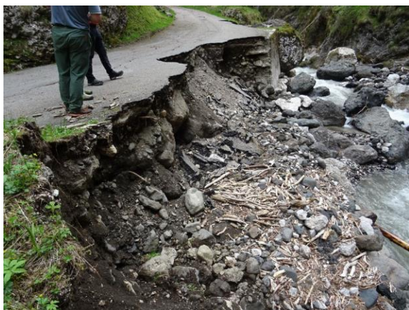
3 – Erosione sede stradale e distruzione arginatura
